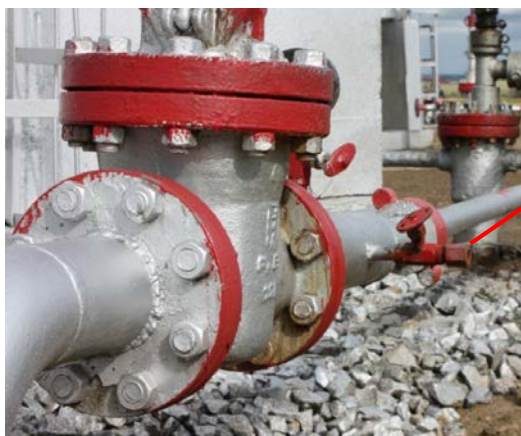
Рисунок 1 – Общий вид устройства для отбора пробы сырой нефти на устье скважины, которое используется на фонде скважин нефтяных компаний
